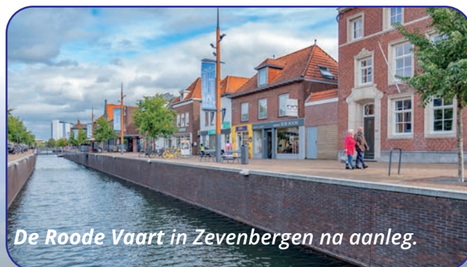
De Roode Vaart in Zevenbergen tijdens aanleg.
